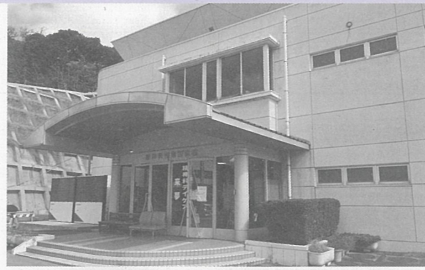
S・IPSの事務所やデイケアが入る作業療法棟
