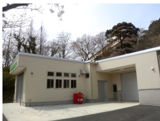
リサイクルセンター外観
